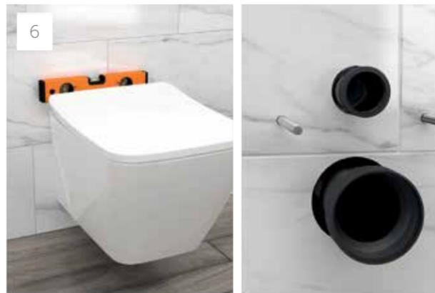
6 Installer la cuvette sur les tiges filetées du bâti support et s'assurer, à l'aide d'un niveau, de la planéité de la cuvette.
