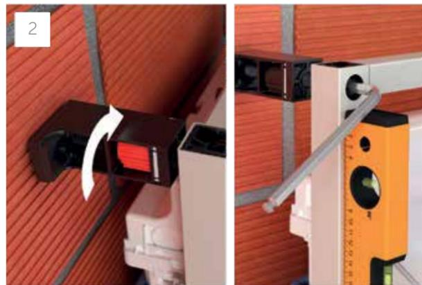
2 Fixer le bâti support au sol et au mur et ajuster les fixations murales EasyFix® permettant le réglage en profondeur du châssis.
